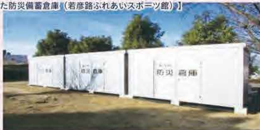
【整備した防災備蓄倉庫（若彦路ふれあいスポーツ館）】
